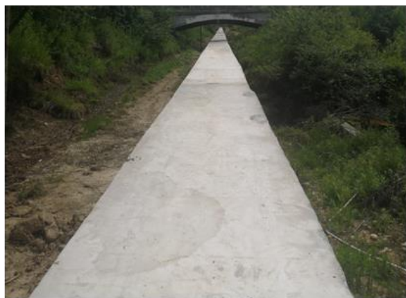
南阳渠提标改造情况
