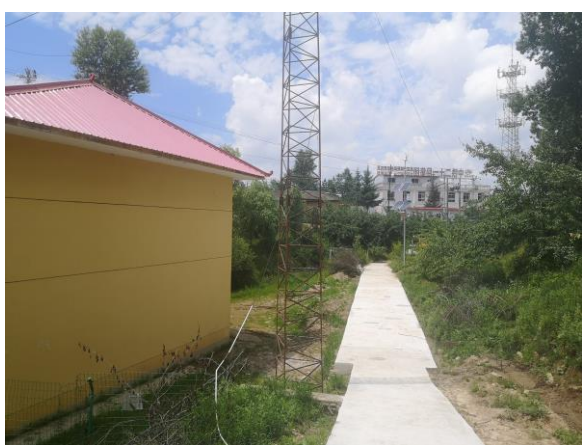
厂区道路两边绿化情况
